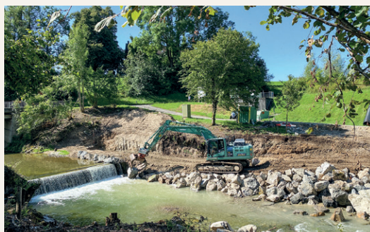
Betonsperre in der Glatt wird durch fischfreundliche Rampe ersetzt.
