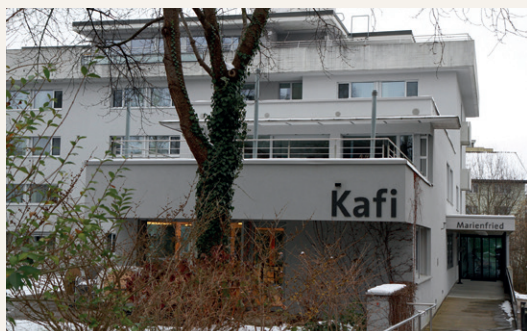
Das Seniorenzentrum Marienfried dient vorübergehend als Flüchtlingsunterkunft. Die Zukunft des Gebäudes ist ungewiss.
